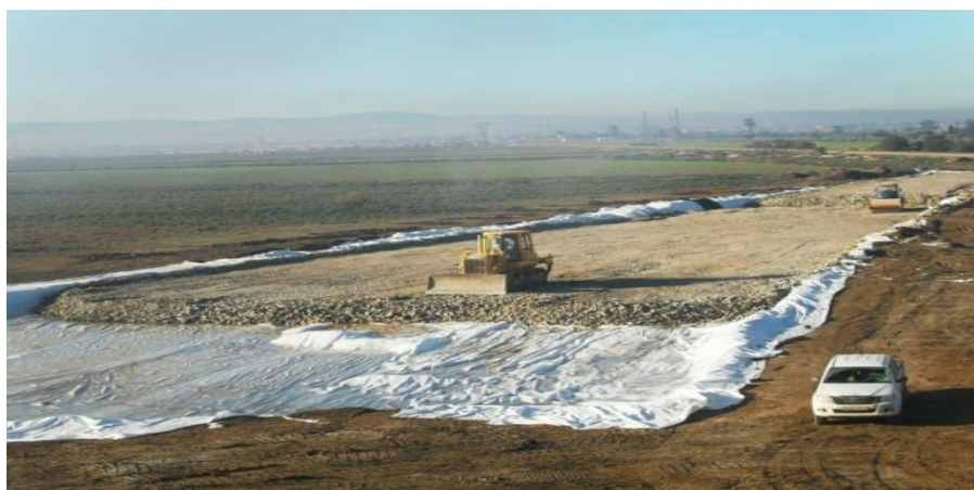
Figure 6. Mise en place du matériau en pierres QS 3 d'épaisseur 500 mm.
