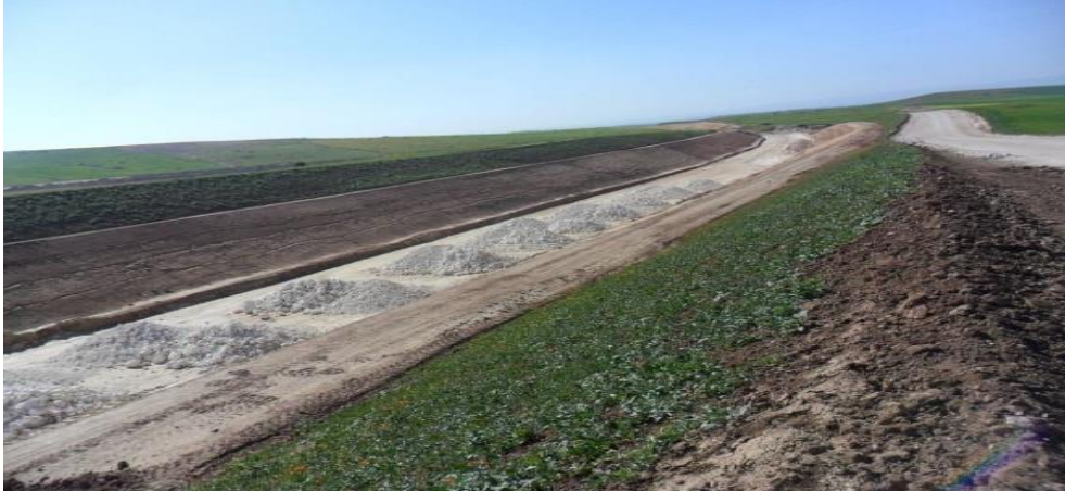
Figure 8. Mise en œuvre de la partie supérieure des terrassements PST
