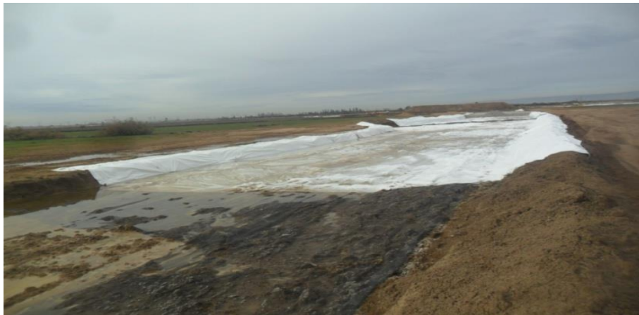
Figure 5 Mise en œuvre de la géogrille et du géotextile 300 g /m 2
