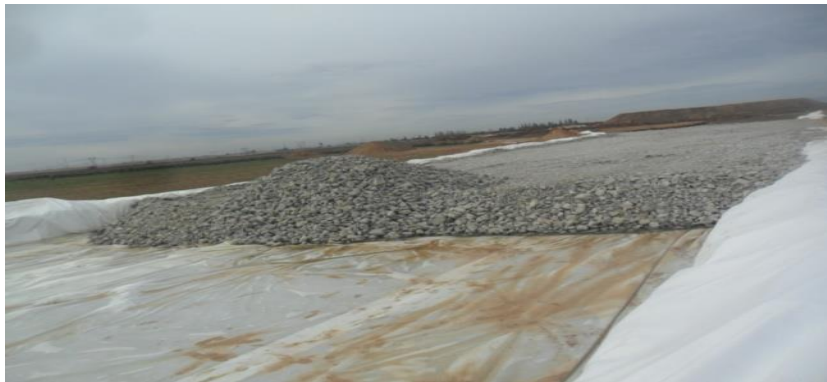
Figure 7. Couche de remblai en pierre matériau QS 3, d'épaisseur 400 mm.
