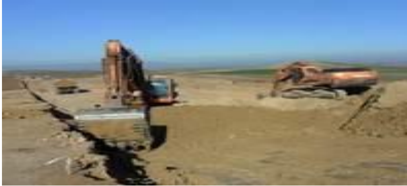
Figure 4. Travaux initiaux décapage de la terre argileuse
