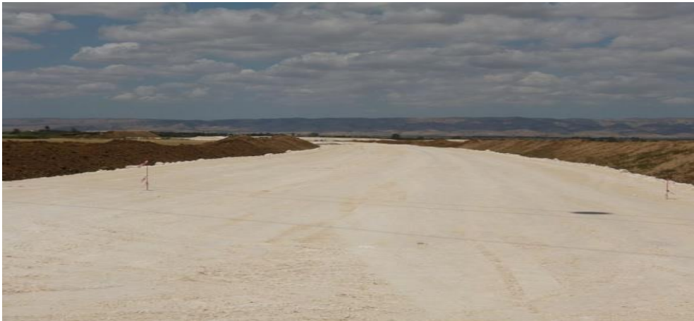
Figure 9. Réalisation de la couche d'assise en grave (0/31,5).
